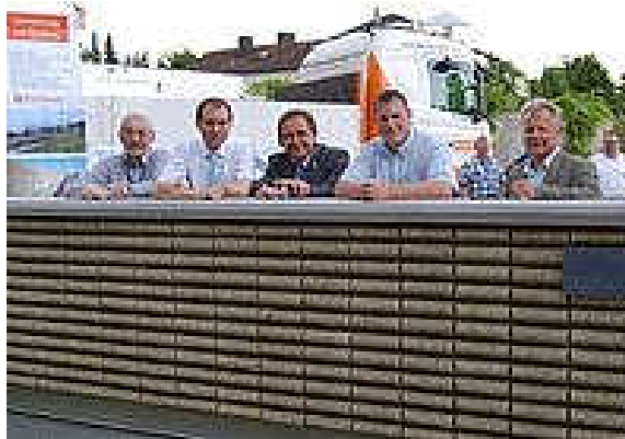
Ein Element der Lärmschutzwand war im Stadtpark zur Begutachtung durch Bürger aufgestellt. Hier ist die Innenseite mit der Oberfläche aus Holzbeton zu sehen. Das Material schluckt den Lärm, die einzelnen Segmente sind an ihrer Basis schmaler als an der Oberfläche. Im Gespräch über die Eigenschaften dieser Wand sind hier (von links) Bernd Passer von der Burghäuser Bürgerinitiative, Denis Kollai und Christian Kubasch von der Südostbayernbahn, Harald Ritter von der Anbieterfirma Rieder und Walther Hinterleuthner, Leiter der Tiefbauabteilung in der Stadtverwaltung. – Fotos: Wetzl
